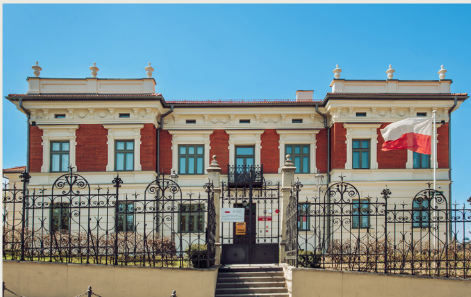
Nowa siedziba MŻKW, fot. D. Kotakowski
