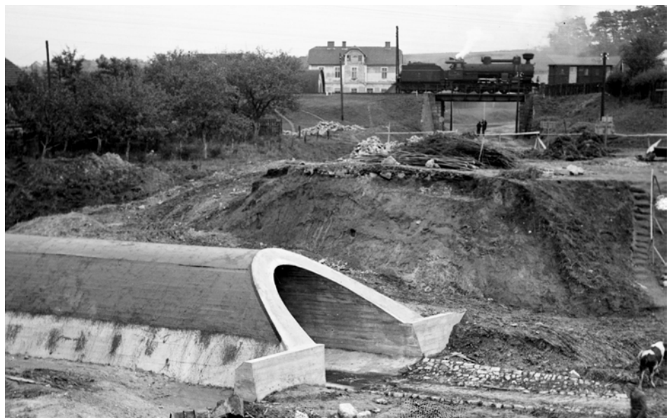
Budowa drogi Kraków-Wieliczka-Lwów, zdjęcie z września 1935 roku. Widoczny przepust drogowy. Narodowe Archiwum Cyfrowe.
